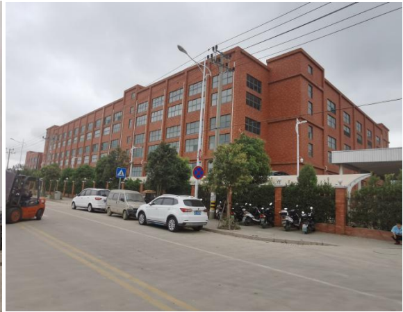
图3 项目区西南侧康德莱老厂区
