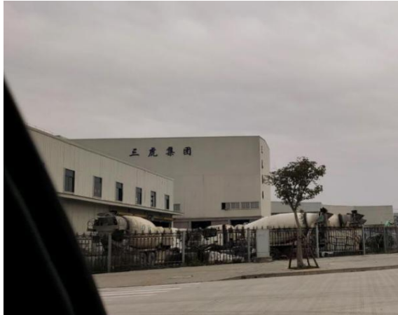
图2 项目区东南侧三虎混凝土
