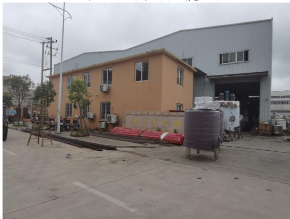
图4 项目区西北侧丰和机械、科信轻工机械
